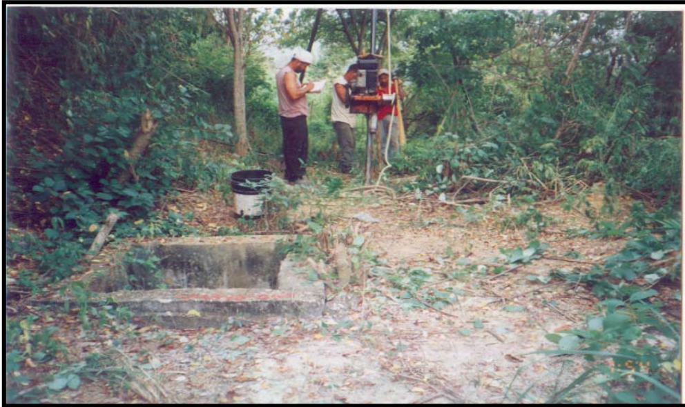
Vista sobre los estudios complementarios realizados para la localización de los pozos profundos
