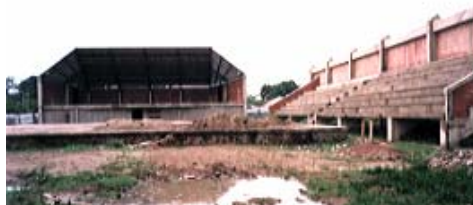
Foto 8. Polideportivo en construcción
