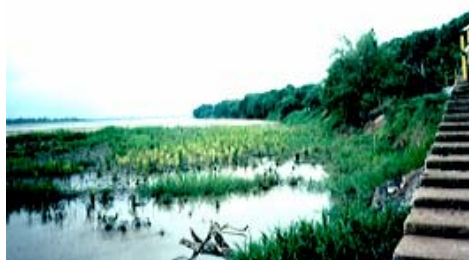
Foto 5. Algunos sectores de la terraza son tan bajos y están tan erodados que en épocas de caudales altos el río alcanza a inundar áreas del Municipio, aguas arriba del Puerto principal.
