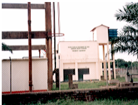
Foto 11 . Planta de tratamiento acueducto.
