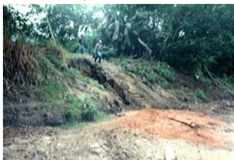
Fotografía 4. Las terrazas aledañas al río Meta en el área urbana presentan un alto grado de riesgo por desprendimiento e inundación.
