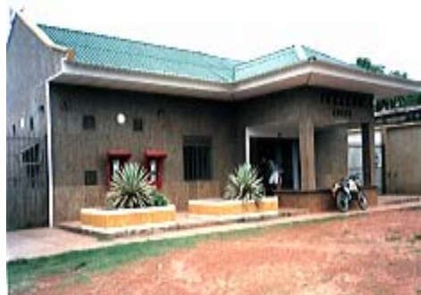
Foto 12. Instalaciones de Telecom.
