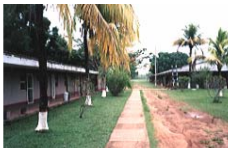
Foto .5. Acceso habitaciones hotel
