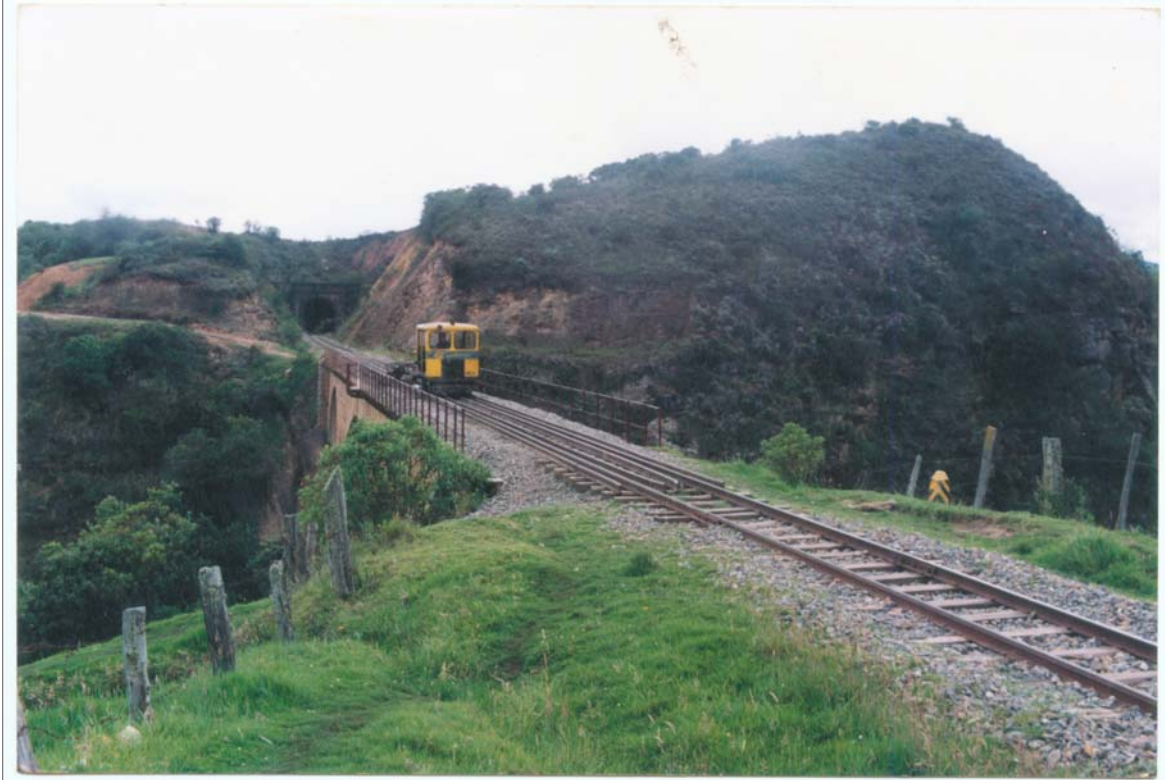
Vía Férrea Sobre el Puente Baurdocci
