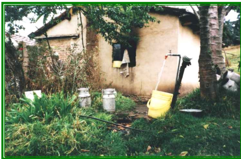
FIGURA No. 35 VIVIENDA DE LA VEREDA DE GAUNZA ARRIBA CON SERVICIO DE ACUEDUCTO DOMICILIARIO, PERO SIN TANQUE DE RECOLECCIÓN ALGUNO
