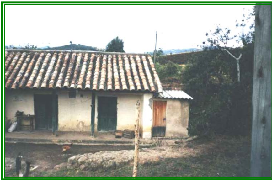
FIGURA No. 34 VIVIENDA DEL SECTOR DE CORTADERA GRANDE CON SU UNIDAD SANITARIA
