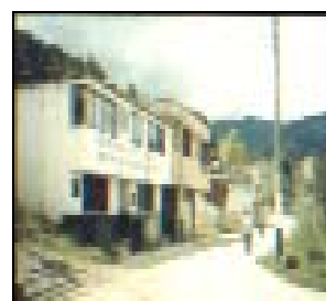
Problemas de andenes
