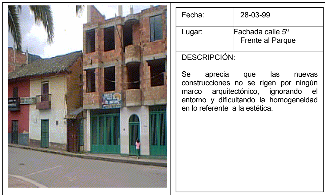
FIGURA No. 9 FACHADA DE UNA VIVIENDA
