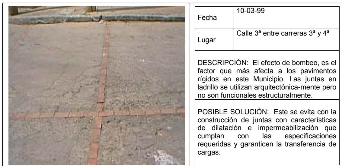
FIGURA No. 34 EL EFECTO DE BOMBEO
