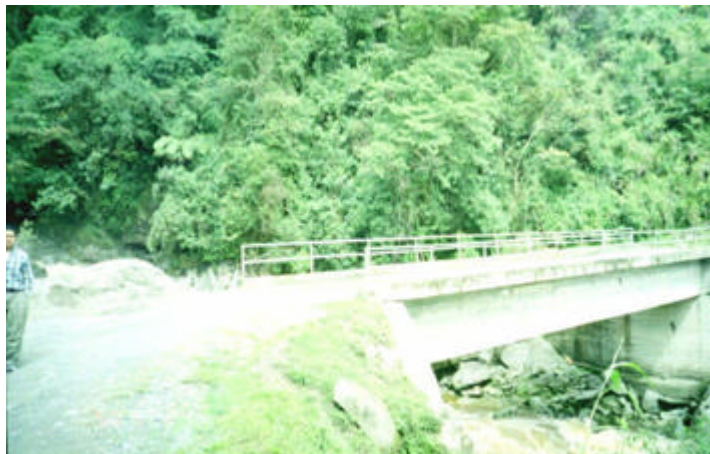
Puente Río Negro – Vereda Yarumal
