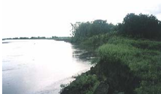
Foto 34. Margen izquierda aguas abajo del río Upía, actualmente deforestada y bajo efectos de socavación. Suelos de la unidad VVFa en la vereda Buenos Aires Bajo.
