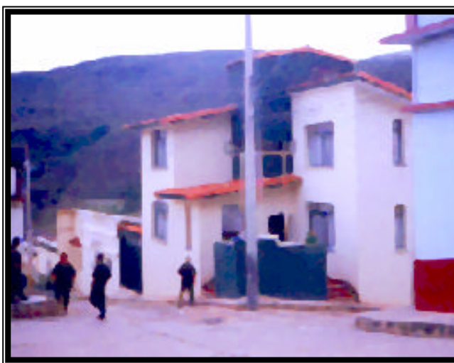
FOTO 16. Subestación de Policía – Betulia.
