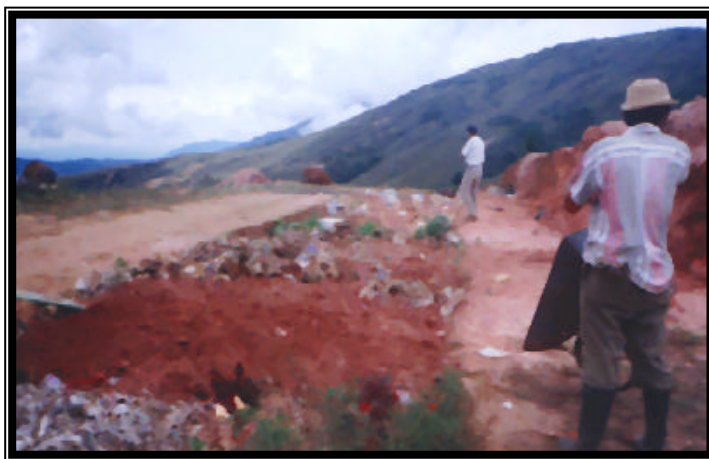
FOTO 21. Relleno Sanitario “El Oso”
