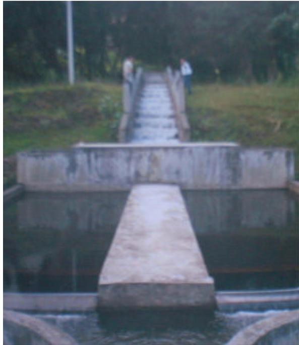
Fotografía 2. Vista de la estructura de aireación y el desarenador de la planta general.
