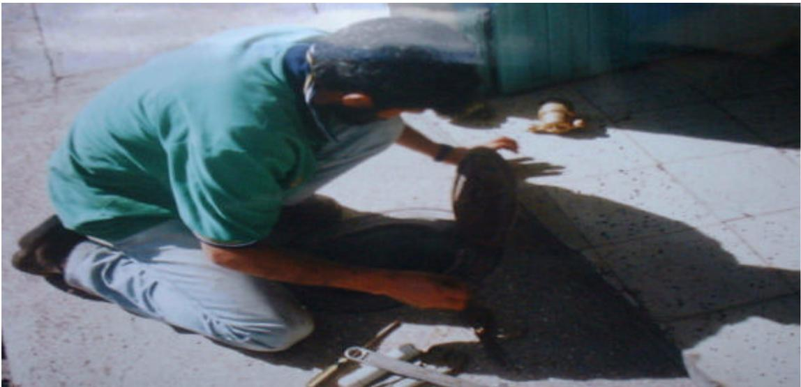
Fotografía 8. Instalación de micromedidor nuevo para un usuario con micromedidor dañado.
