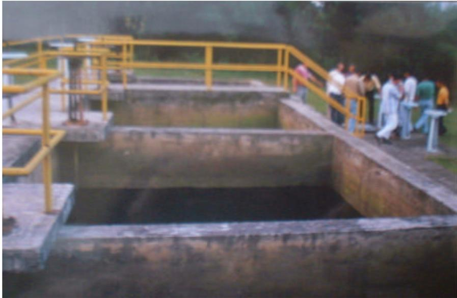
Fotografía 4. Vista de las cuatro unidades de filtración.
