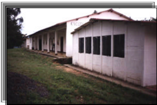
FOTO 2: Escuela rural San Roque de Picacho
