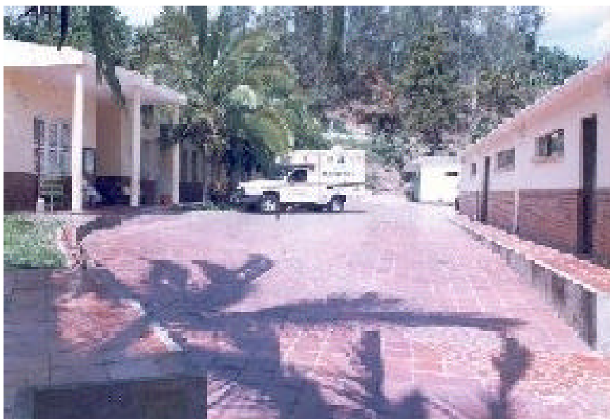
Figura N° 1. Hospital San Norberto de Durania.
