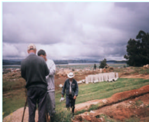
Foto 3: Trabajos para la construcción de vivienda de interés social. El Oasis, 2003.
