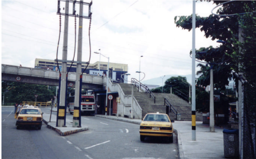
Acceso a la estación del Metro El Poblado - costado oriental.
