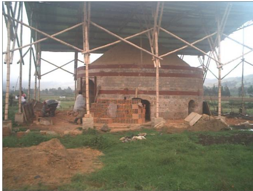
Figura 4. Propuesta construcción horno colmena-cocción de ladrillo
