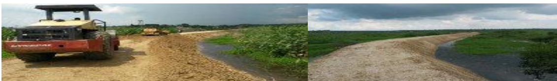
Fotos reconformación de Dique de contención en Carreto municipio de Candelaria.
