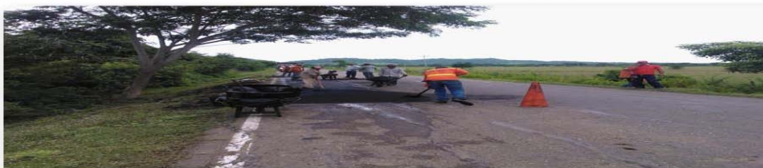
Mantenimiento de la vía Repelón-Villa Rosa-Puerto Limón.
