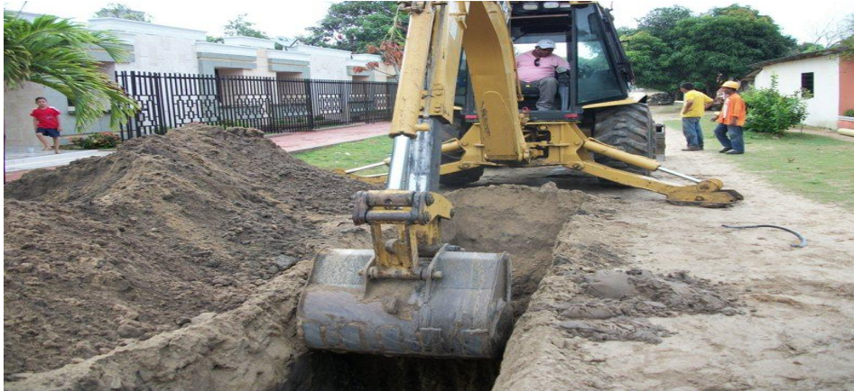
Excavaciones para redes de alcantarillado
