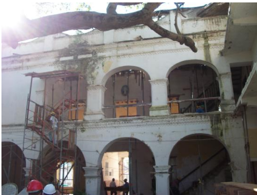
Casa Museo antes de la restauración
