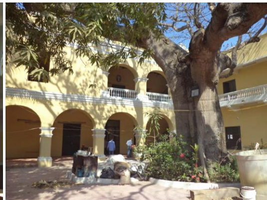
Después de la restauración
