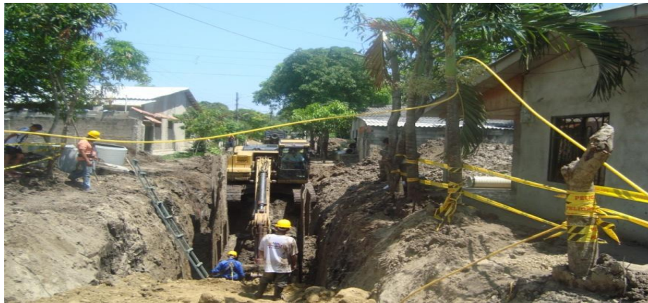
Excavaciones profundidades mayores a 6 metros.
