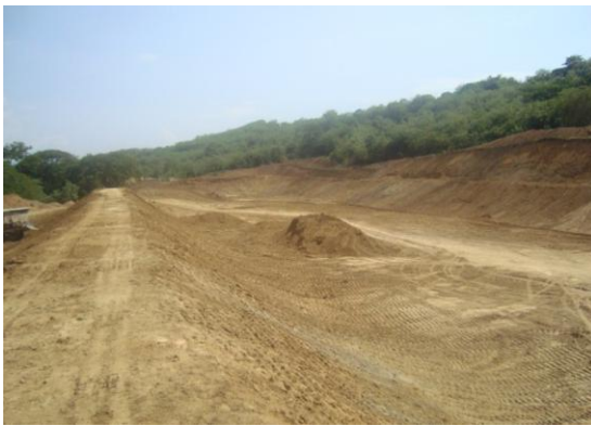
Construcción de la Laguna
