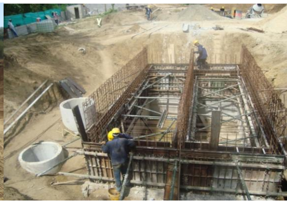
Construcción de Tanque
