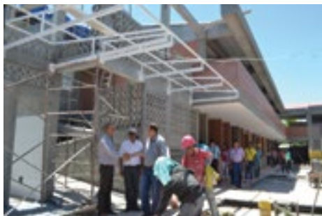
Construcción Megacollegio, Espinal - Tolima
