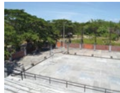
Remodelación villa deportiva, Espinal - Tolima
