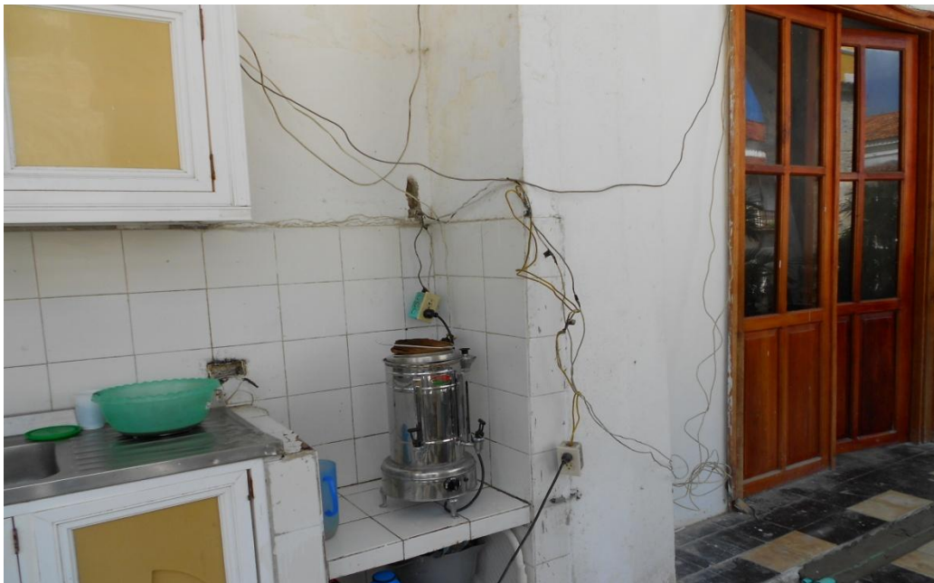
Cafetín instalado y enchapado en el balcón al lado del Despacho Gobernador
