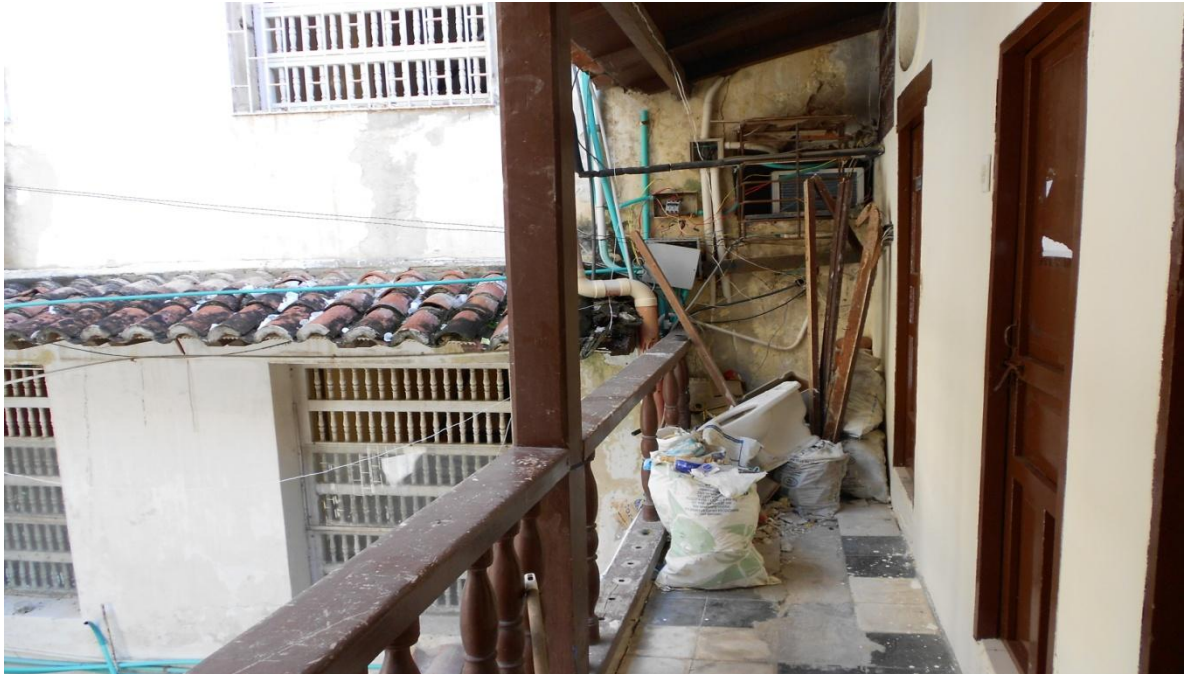
Balcón Interno de acceso a los baños
