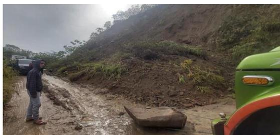
*Nota:* en la figura se puede observar la constante problemática de deslizamientos que se desarrolla en las carreteras del municipio, debido a las grandes precipitaciones y la inestabilidad de los taludes. Tomado de un artículo periódico de (Caracol, 2022).
