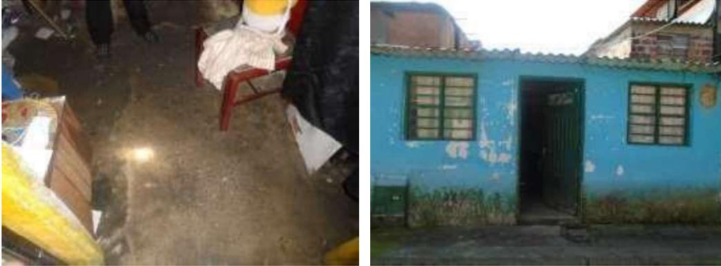
La capilaridad de pisos y muros no es atendida porque los recursos del subsidio son limitados, en la priorización se seleccionó estructura y cubierta.
