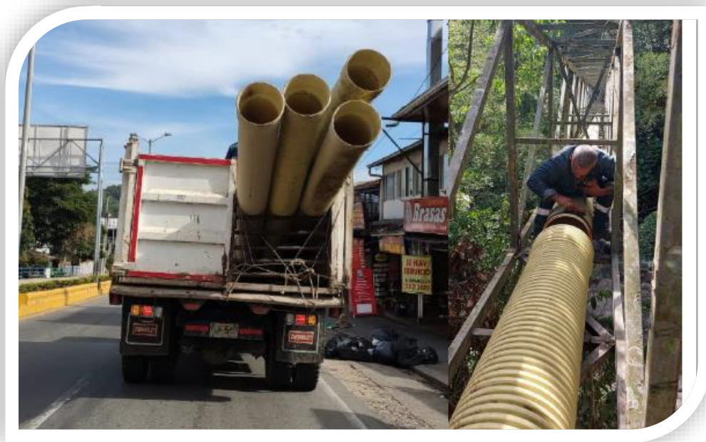
Figura 20. Renovación viaducto llegada PTAR
