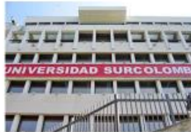
Subsede Torre Administrativa y Postgrados Cra.5 No. 23-40 / Barrio Sevilla
