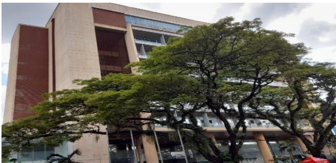
Ilustración 1. Edificio de la gobernación del Meta. Foto personal
