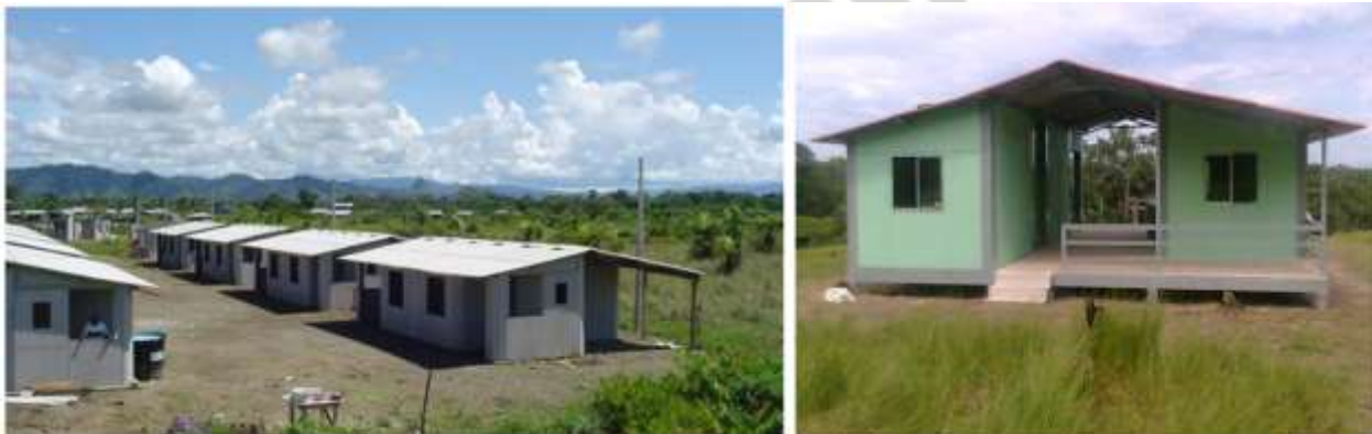
Figura 17. Proyectos de vivienda en Turbo (Antioquia) y en La Macarena (Meta) en zonas de clima cálido húmedo con arquitectura liviana. Fuente: Eternit, 2020
