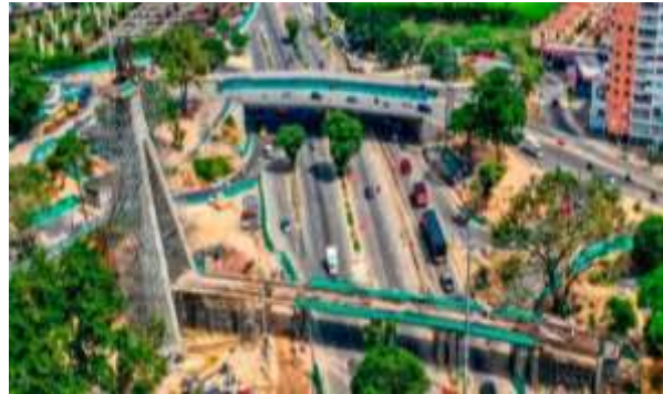
Ilustración 34. Avance Construcción Intercambiado PQP. Fuente: Web Vanguardia.com
