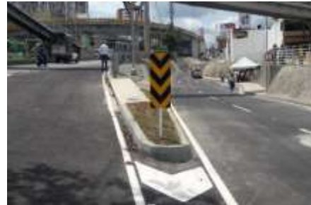
Ilustración 32. Obra Tercer Carril. Fuente: Web Floridablanca.gov.co
