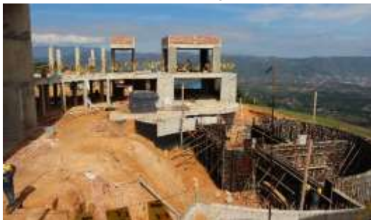
Ilustración 35. Avance de Obra Parque Parapente. Fuente: Web Floridablanca.gov.co
