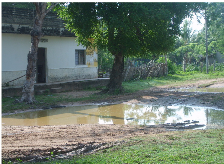
Vía en mal estado (callejón)
