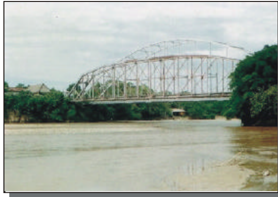
Panorámica del puente Ospina Pérez sobre el río Saldaña.
