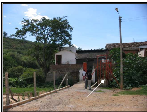
Foto 21: Fachada matadero municipal sitio de acceso de embarcadero.
