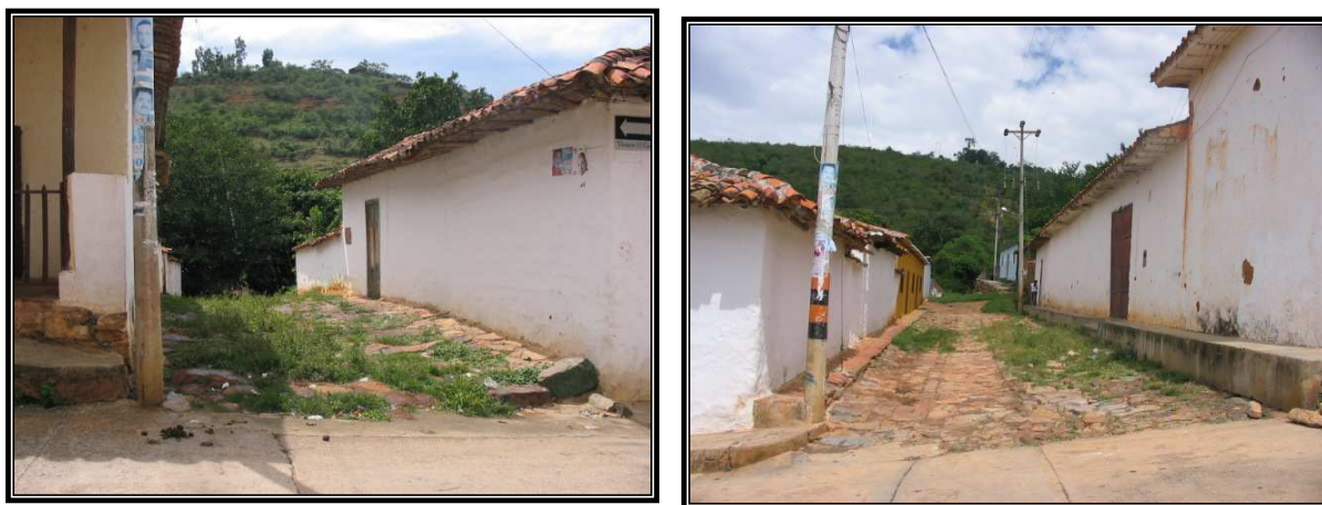
Foto 19 – 20: Vías urbanas sin capa de rodadura.
