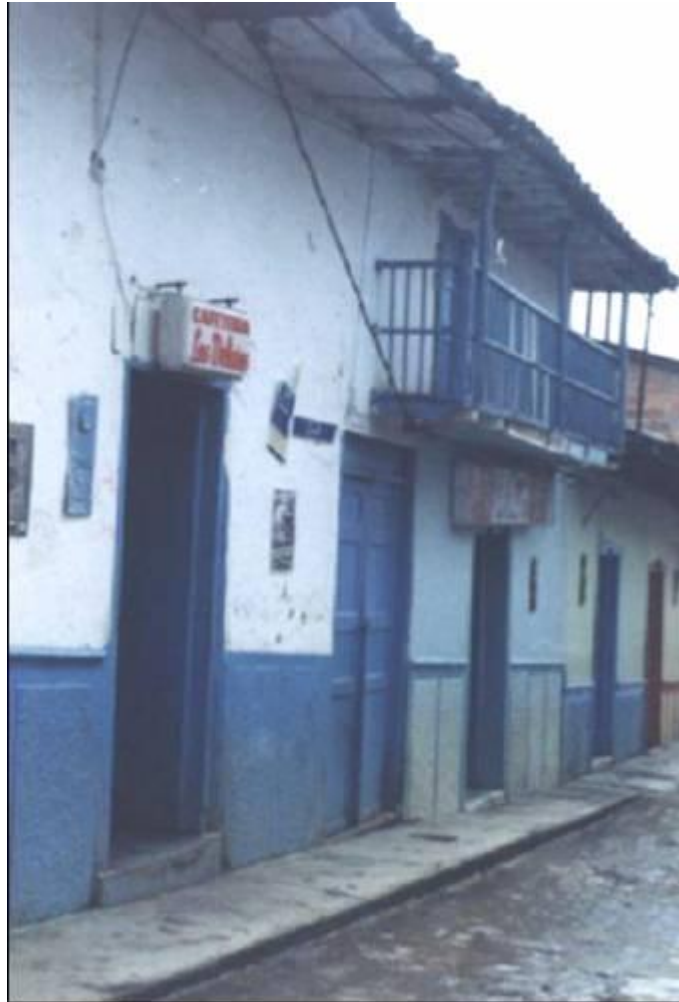
Foto No.18 Fachadas y Balcones
