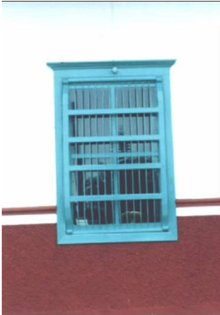
Foto No 15. Casa Cural. Ventana
