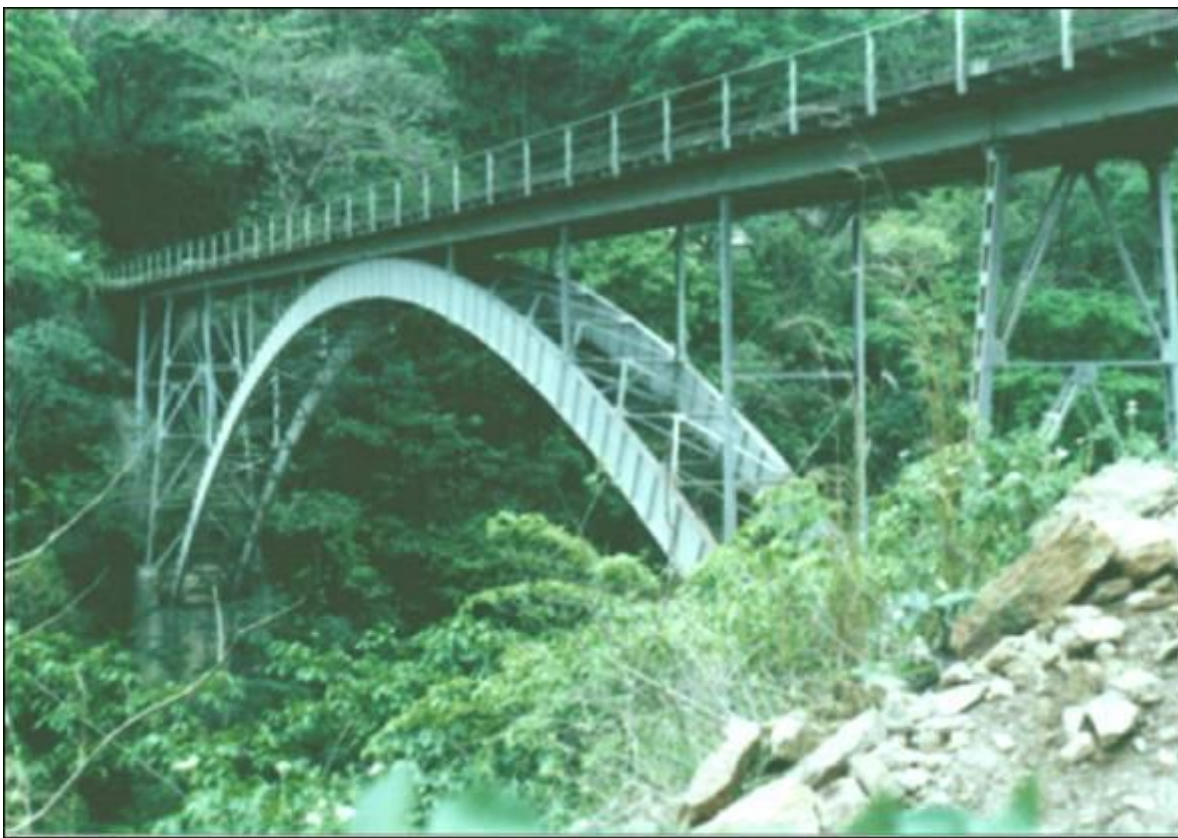
Foto No.12 Puente Juan de la Cruz Posada o Pescadero. Vista Lateral
