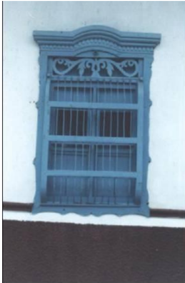
Foto No 16 Ventana en Madera
