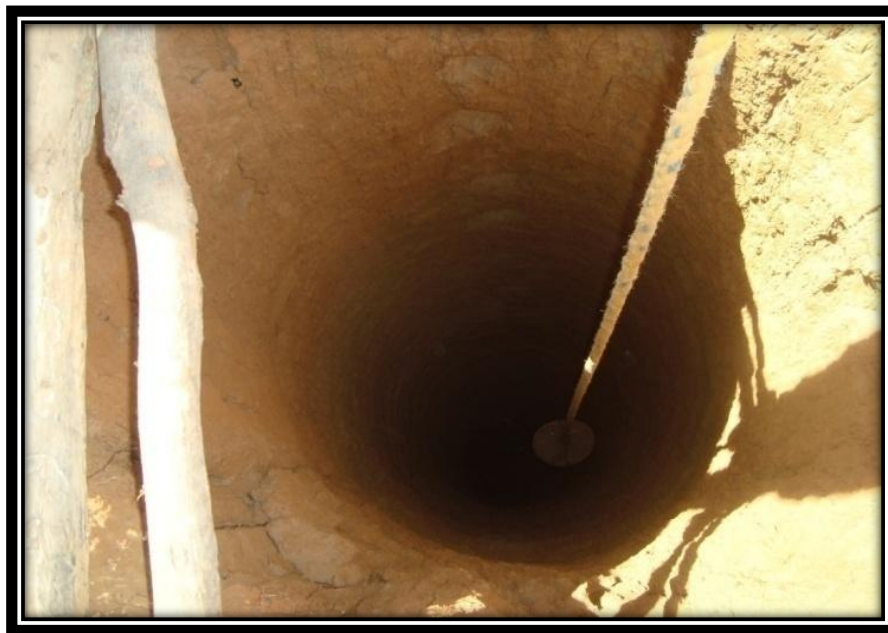
Fotografías: Construcción de nuevas alternativas (pozos Artesianos) para el mejoramiento y mantenimiento del servicio agua potable para las comunidades de la zona rural del municipio de Uribe.
