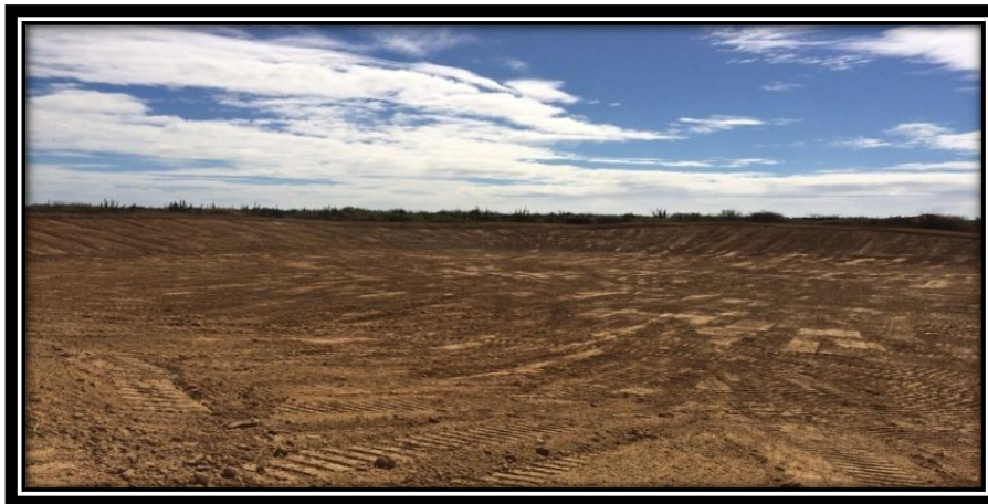
Fotografía. Compactación del talud en forma perimetral por capas y estado final del reservorio apta para llenado
