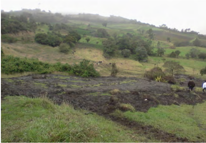
Fotografía 49. Zona de deslizamiento
