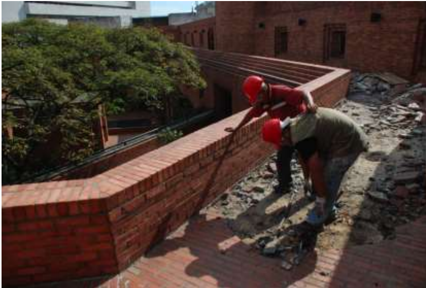
Programa de conservación de la edificación Centro Cultural de Cali.
