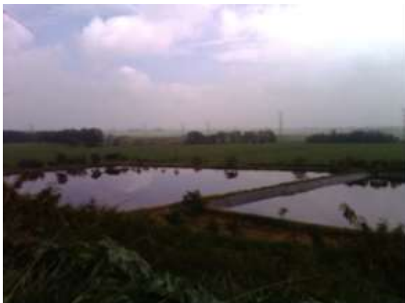
Laguna de lixiviados sitio disposición final de Navarro
