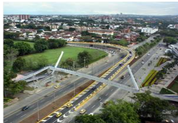
Registro fotográfico Obras de la zona
