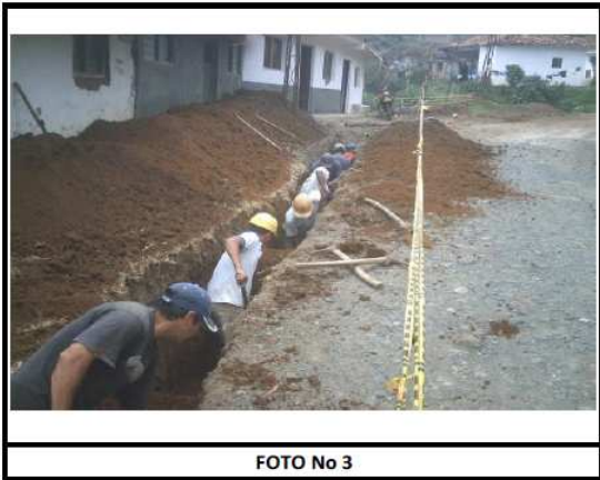
Vista de los trabajos adelantados.
