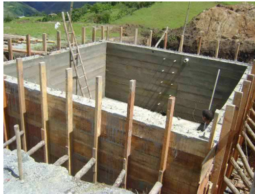
Foto. Mantenimiento Abastecimiento Vereda Loma Grande
