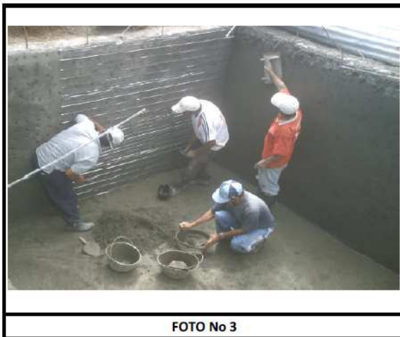
Vista de los trabajos adelantados.
