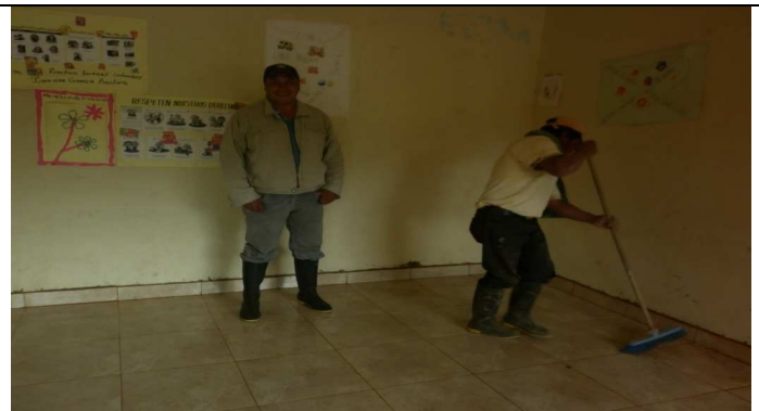
Adecuación Piso Restaurante Escolar Porvenir
