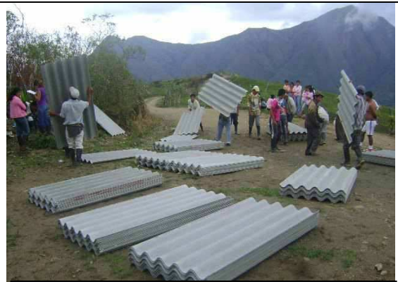
Mejoramiento de Vivienda
