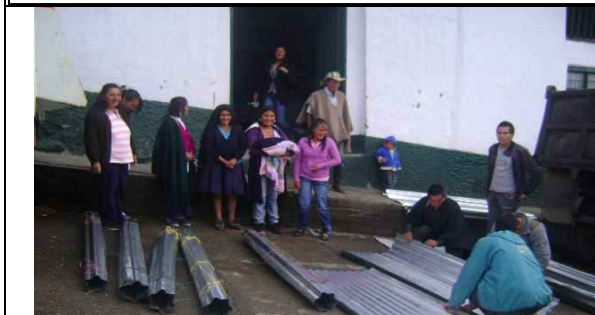
Mejoramiento de Vivienda
