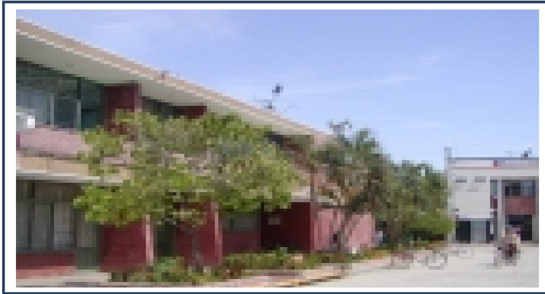
Edificio Alcaldía de Saldaña
