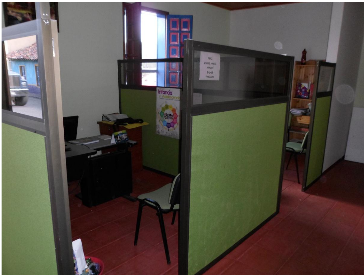
MANTENIMIENTO Y ADECUACIÓN DEL DESPACHO PARA LA COMISARIA DE FAMILIA EN EL EDIFICIO DE LA ALCALDÍA DEL MUNICIPIO DE TÓPAGA BOYACÁ
