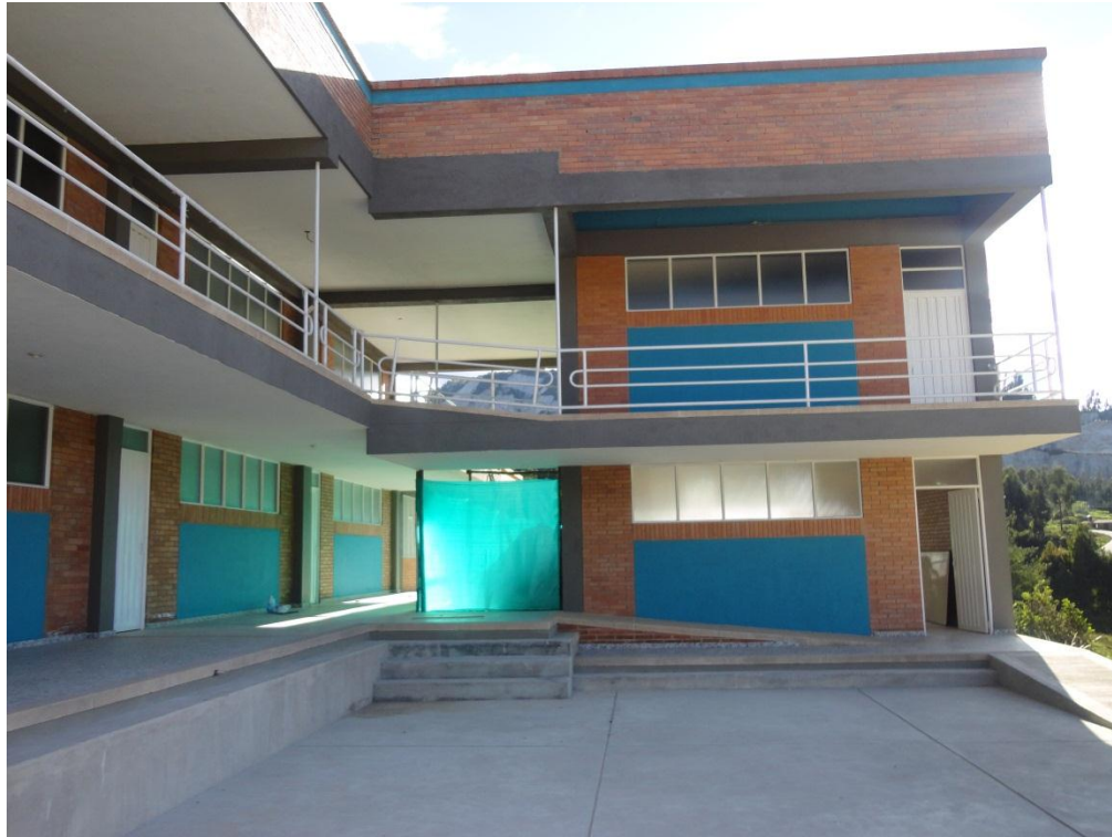
1A Y 2A PLANTA DE LA NUEVA SEDE DE LA INSTITUCION EDUCATIVA VADO CASTRO DEL MUNICIPIO DE TOPAGA
