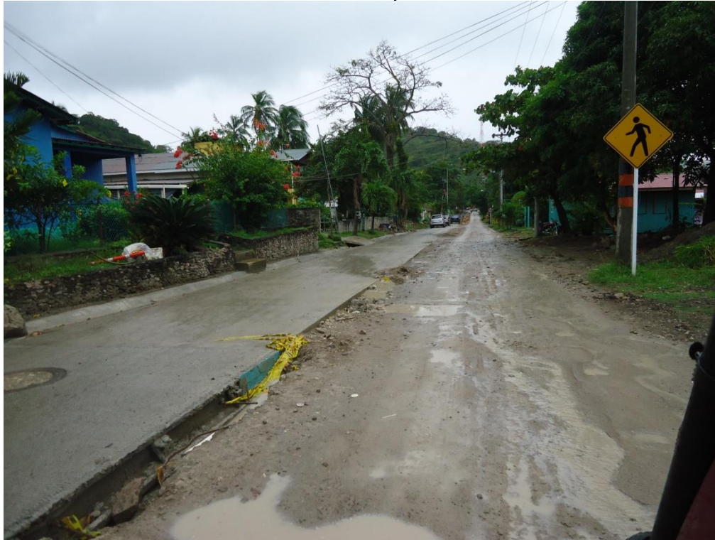
Foto 31: Avenida Circunvalar en reparación en el sector turístico
