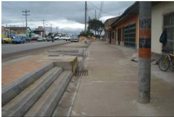
ANDENES VÍA VEREDA PUENTE DE PIEDRA
