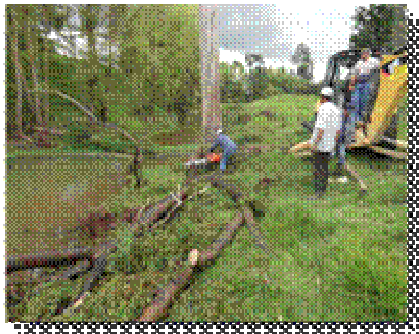
LIMPIEZA RONDA RÍO URB. PIJAOS
