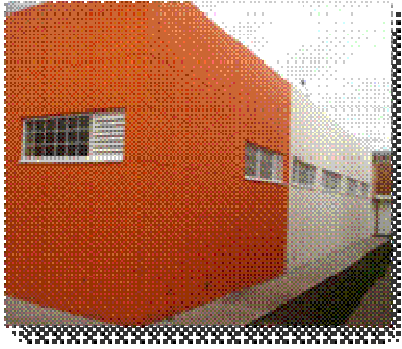
BARRIO PUERTAS DEL SOL
