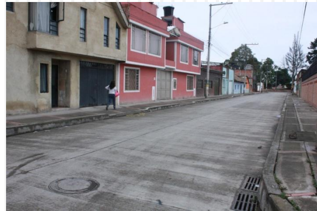
Pavimentación Calle segunda
