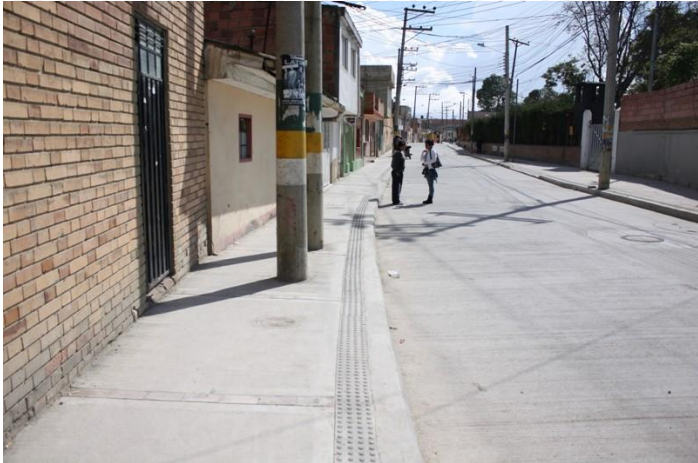
Pavimentación Carrera Novena
