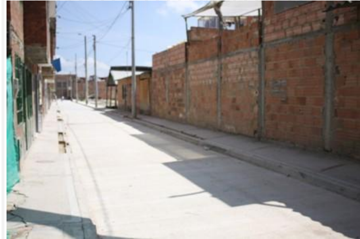
Pavimentación vía Primero de Mayo
