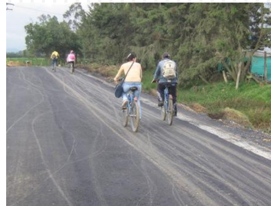
Pavimentación vía Madrid –Puente Galindo
