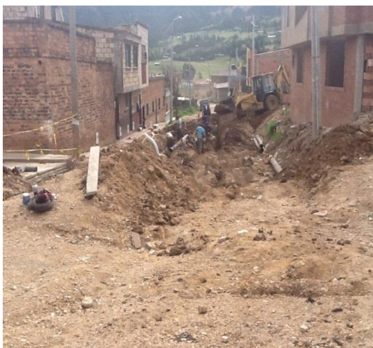
Cambio de tubería en la calle 1 del Municipio
