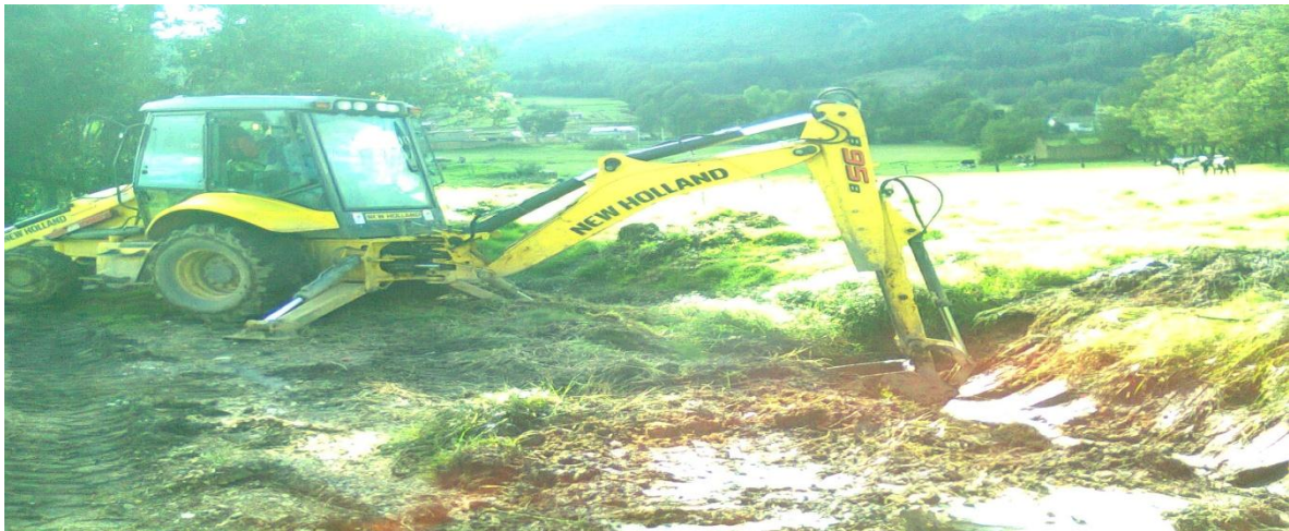
Limpeza desagüe aguas lluvias sitio San Antonio
