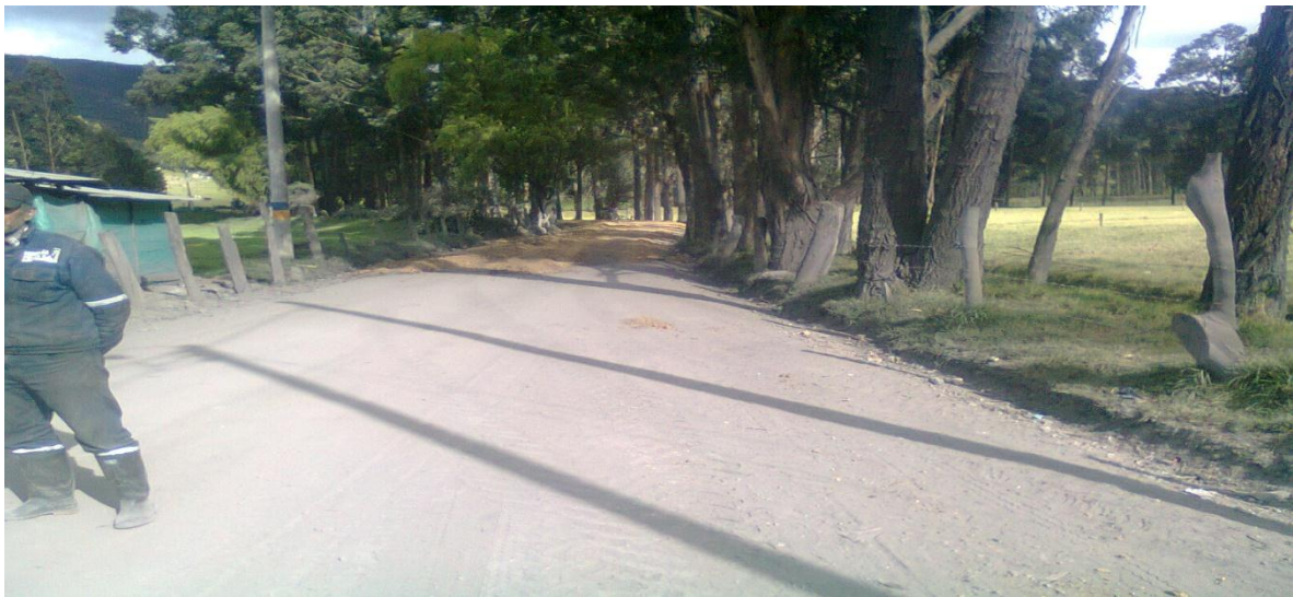
Arreglo vía El Boquerón - El Salto
