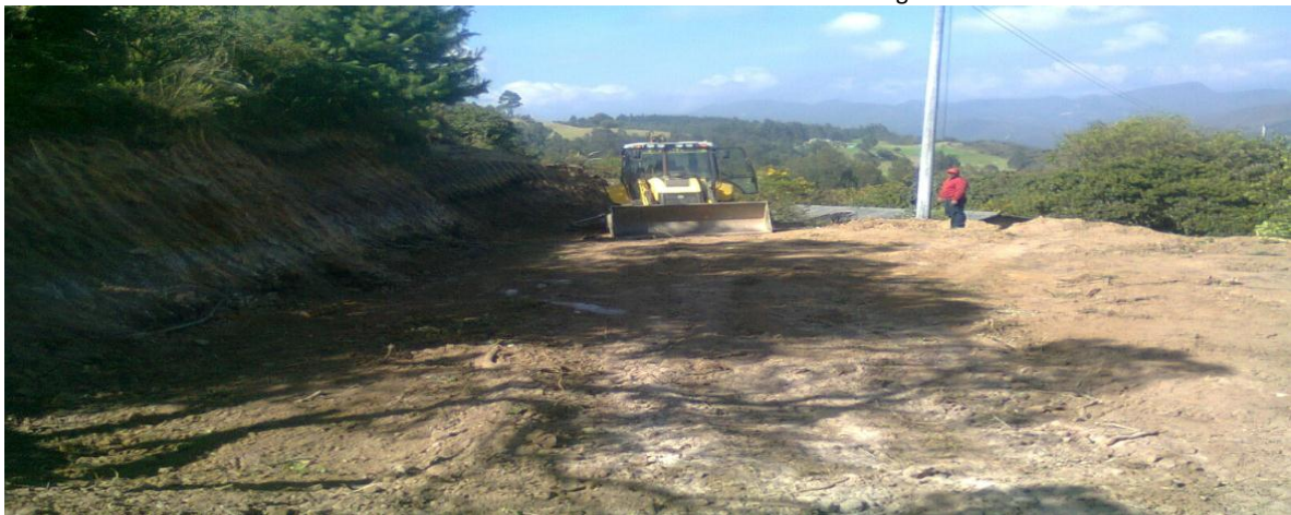
Deslizamiento de tierra
