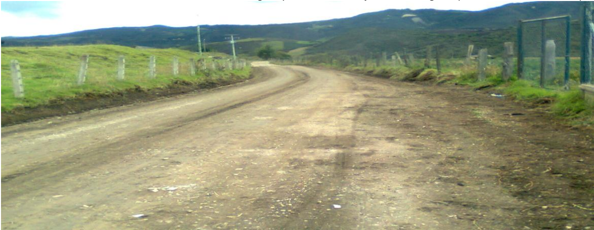
Arreglo de la vía el Alisal sitio las piedras
