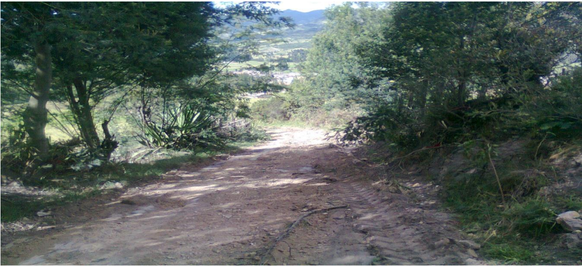
Arreglo de la vía altos de horizonte limites con Cucunuba
