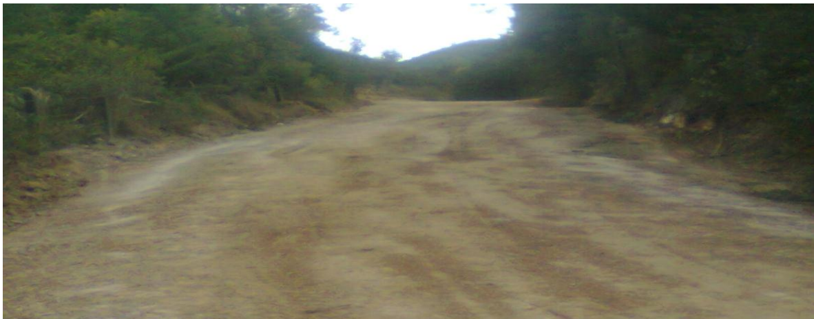
Arreglo vía Chirvaneque – Faracia
