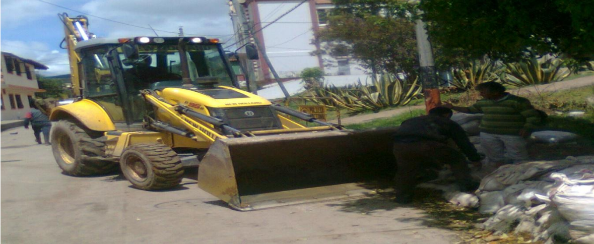
Construcción muro de contención
