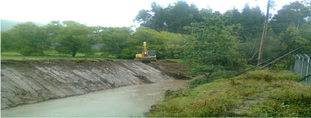
Dragado y conformación de jarillón Río Lenguazaque sector Matadero Municipal
