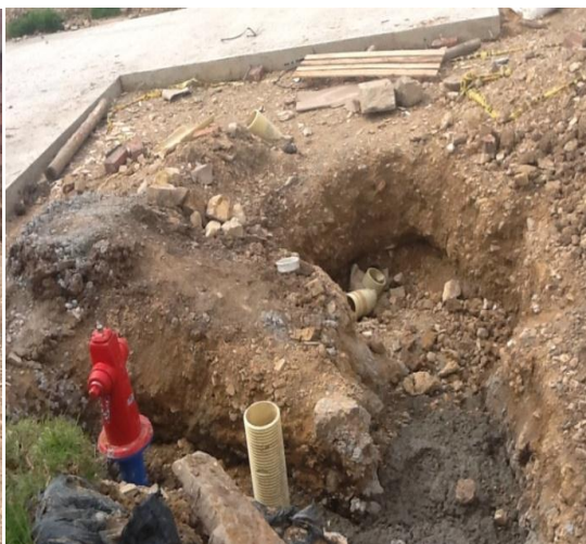
Instalación del hidrante en la calle 6
