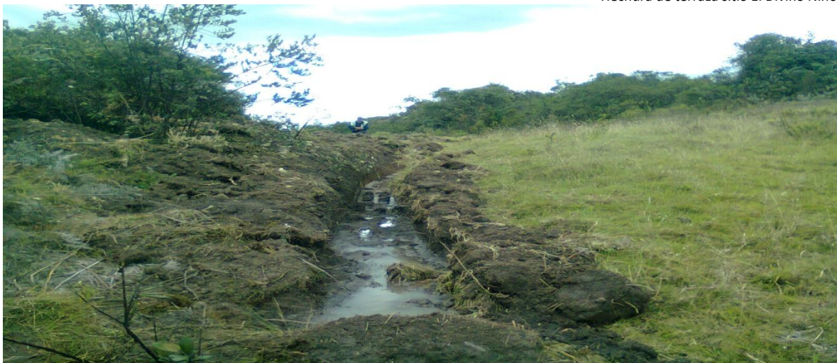
Hechura de zanja para evitar filtración de agua
