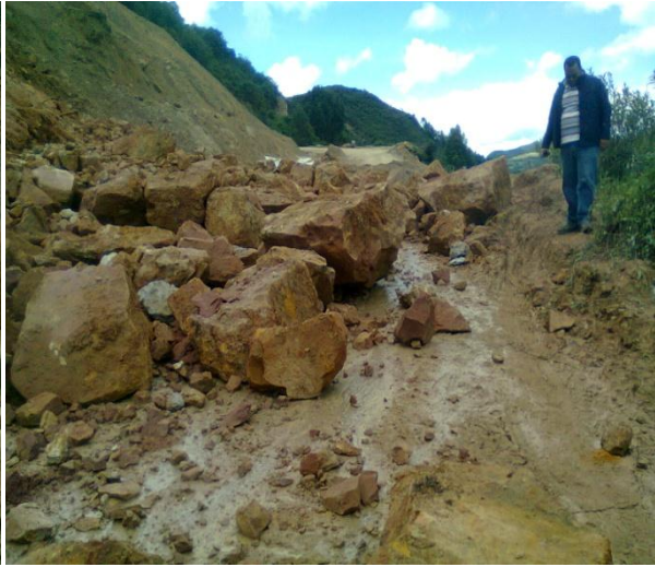
Deslizamiento y caída de piedras
