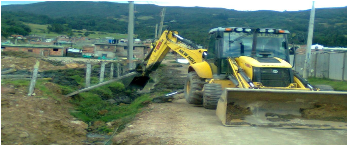
Limpeza colector aguas lluvias calle 1
