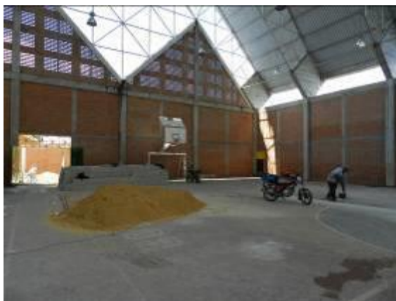
Cambio de piso Polideportivo Municipal "Julio César Sánchez"
