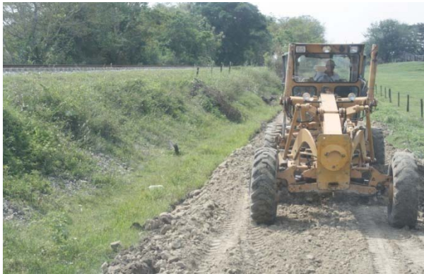
Trabajos en vía La Dorada Buenavista
