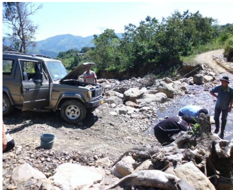
Vía Curisi-Charanga, Quebrada la Charanga
