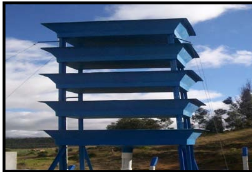
Figura 3. Planta de tratamiento de agua potable
