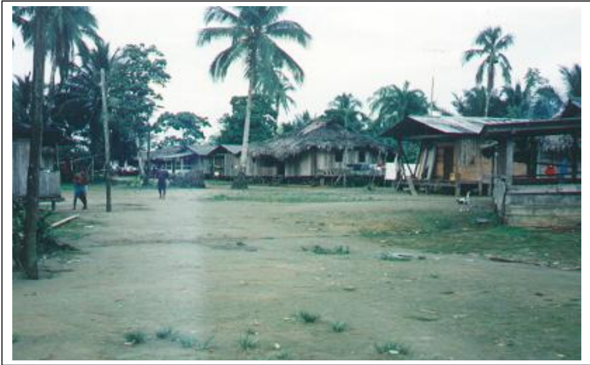
Figura 7: Vivienda Tipo Municipal
