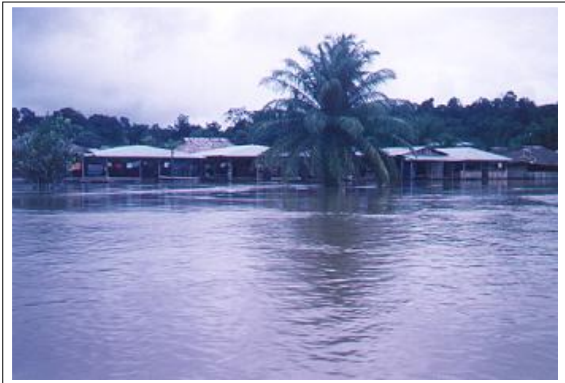
Figura 8: Vivienda rural en Inundación
