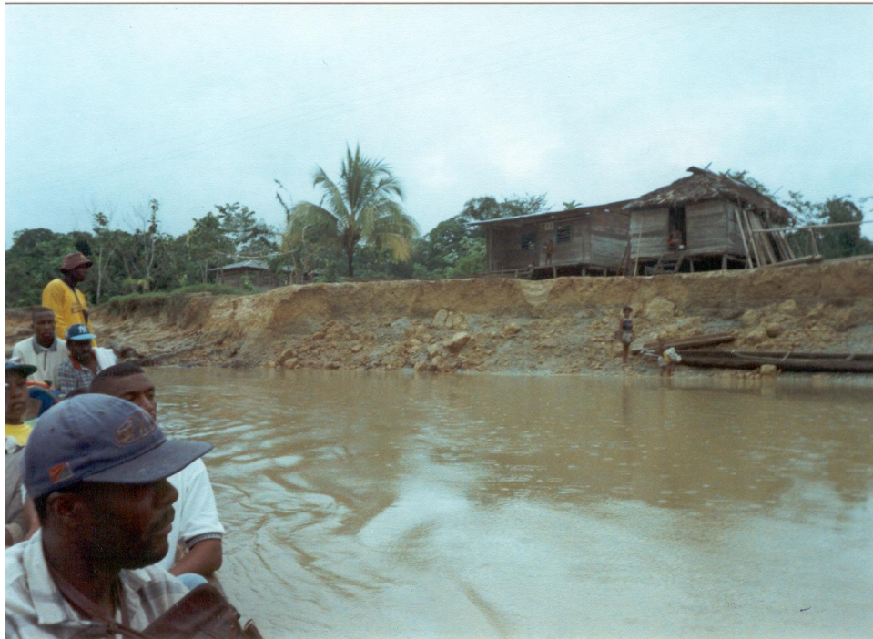
EROSION EN LAS RIVERAS DEL RIO EN LOS SECTORES POBLADOS
