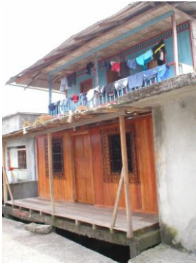
Foto de vivienda Palafítica de dos plantas, Sector de Los Puentes.
