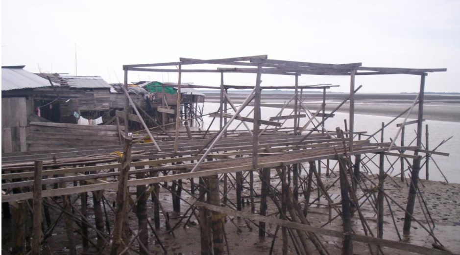
Foto del Barrio María Auxiliadora. Fuente: Tashy Ltda. 2006
