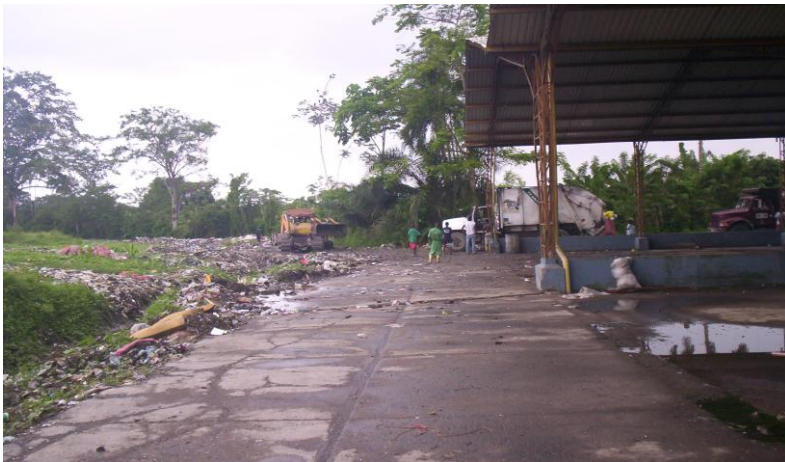
Planta de tratamiento de residuos sólidos de Tumaco y las celdas de relleno sanitario, Fuente: Tashy 2006
