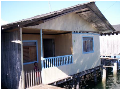
Foto de vivienda Palafítica, Barrio Brisas del Mar.
