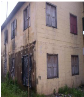
Foto de viviendas en concreto, Proyecto ALA, Barrio La Ciudadela.
