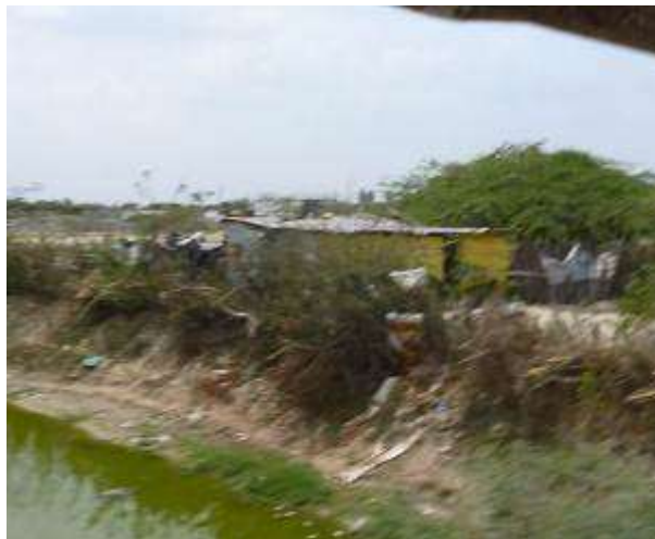
Fotografía 9. Vivienda en zona de amenaza de inundación
