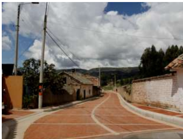
Adoquinamiento y placa huella Vía al Cementerio
