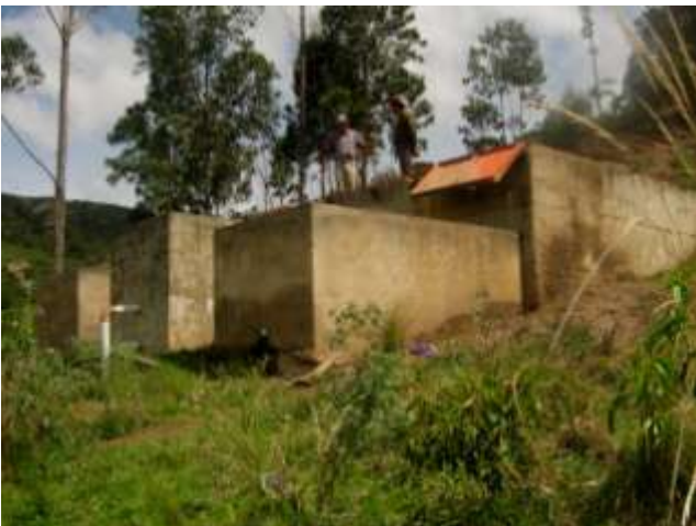
Planta de Tratamiento Vereda Cuesta en Medio antes del mantenimiento.
