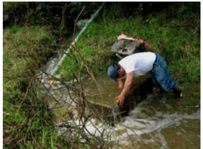
Limpieza de captaciones y tanquillas
