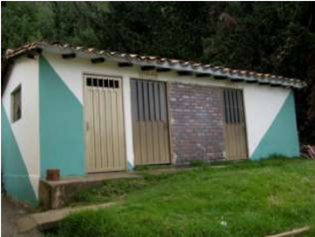
Mantenimiento Bateria Sanitaria Institución Educativa San Felipe Sede Simón Bolívar.
