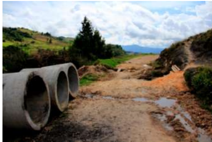
Construcción Alcantarillas Vereda Escalones. Colombia Humanitaria
