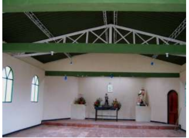
Terminación Salón Comunal Vereda Escalones
