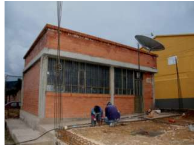
Construcción Aula de Sistemas Institución Educativa "San Felipe" Sección Secundaria. CANAPRO
