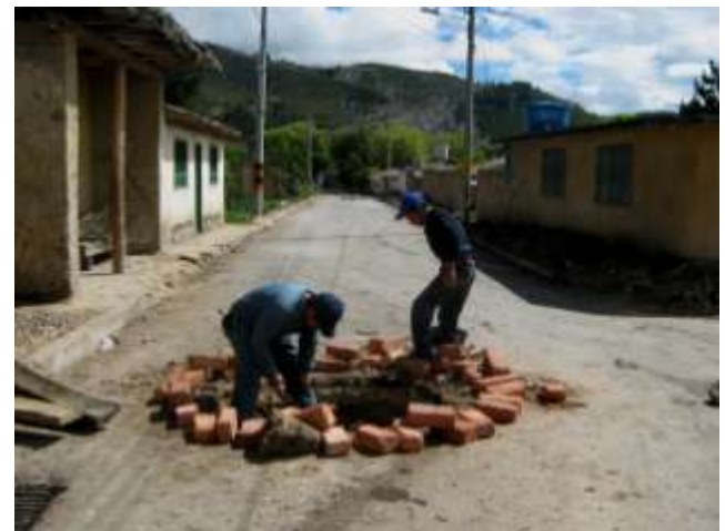
Adecuación acueducto y alcantarillado Carrera 4
