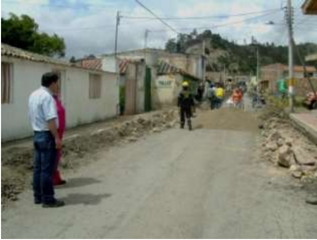
Ampliación Redes Gas Natural
