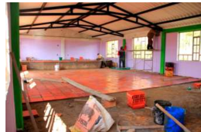
Construcción Salón Comunal Vereda Pijaos Parte Alta
