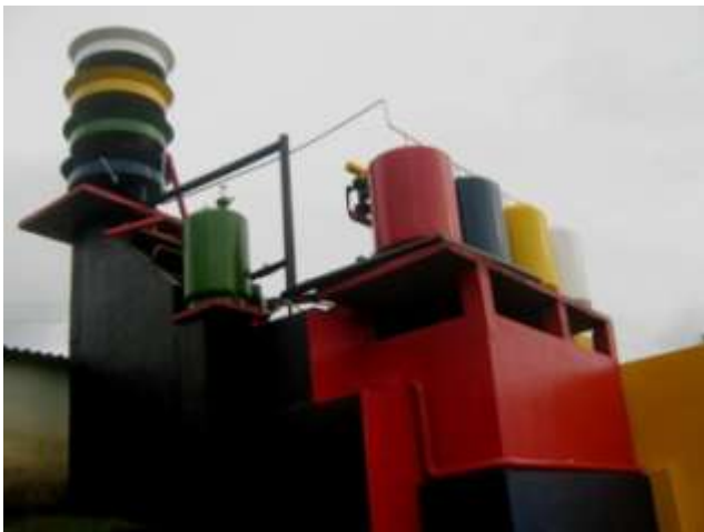
Mantenimiento Planta de Tratamiento Acueducto Casco Urbano
