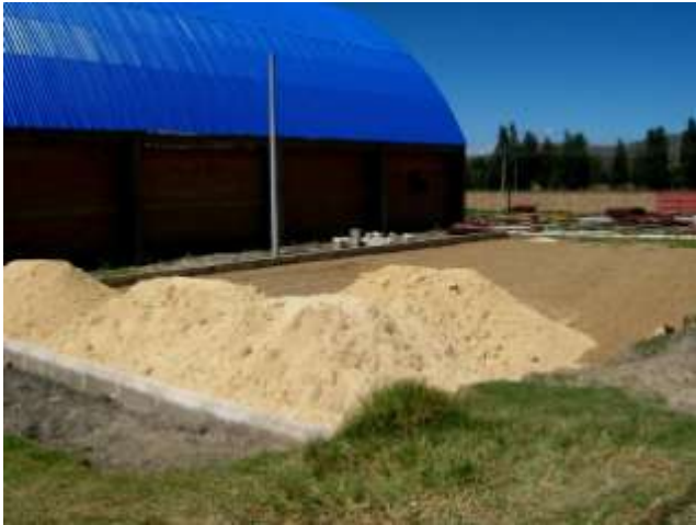
Construcción Cancha de Voley Playa
