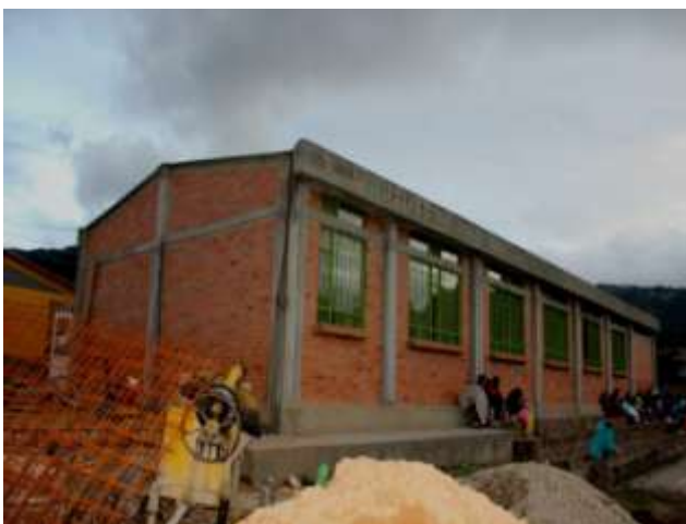
Construcción Aula Máxima Institución Educativa "San Felipe" Sección Secundaria. Convenio Gobernación de Boyacá
