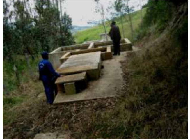
Limpieza de captaciones y tanquillas
