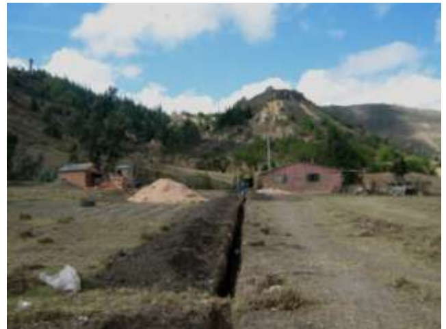
Construcción Acueducto Sector La Avenida,
