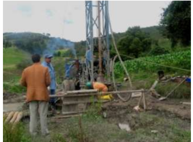
Construcción Redes de Acueducto del Pozo Profundo a la planta de tratamiento,
