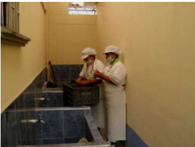
Adecuación lavaderos y cocina Institución Educativa San Felipe Sección Secundaria
