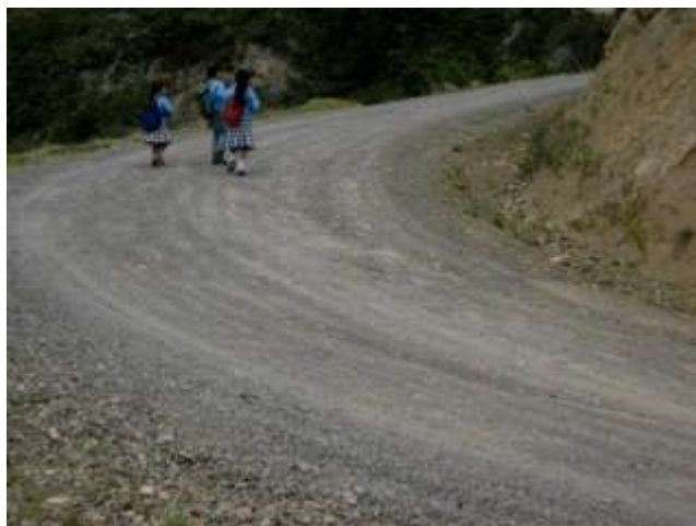
Mantenimiento Vías Rurales
