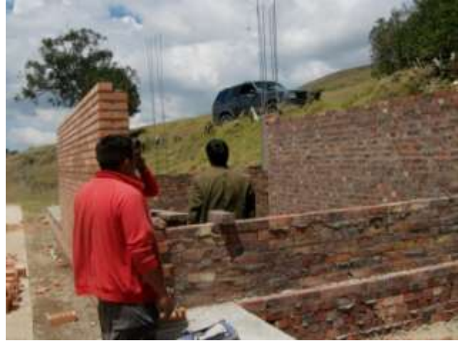
Construcción graderías Vereda Chipacatá
