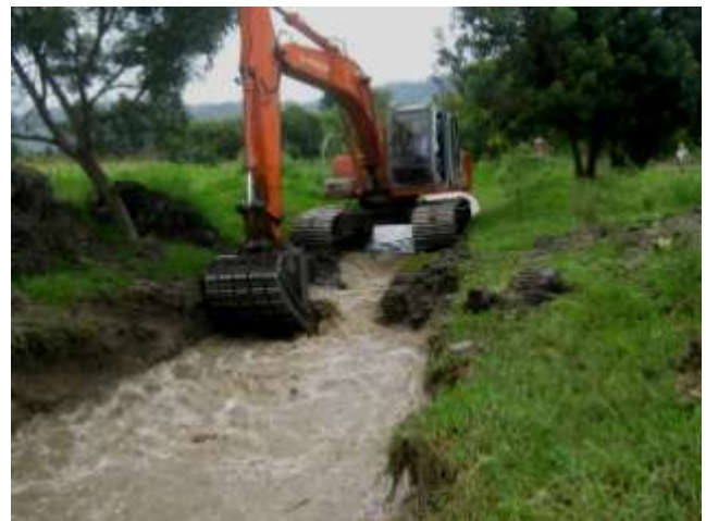
Limpieza de Quebradas
