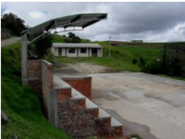
Construcción Graderías Polideportivo Vereda Chipacatá
