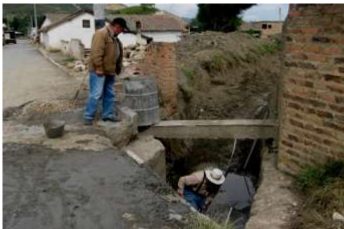
Canalización de la Quebrada Santiago
