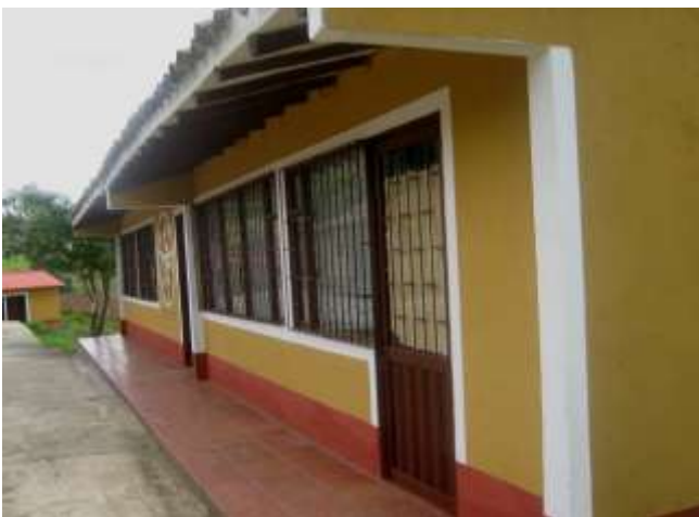
Mejoramiento de la Institución Educativa San Felipe. Sede Escalones
