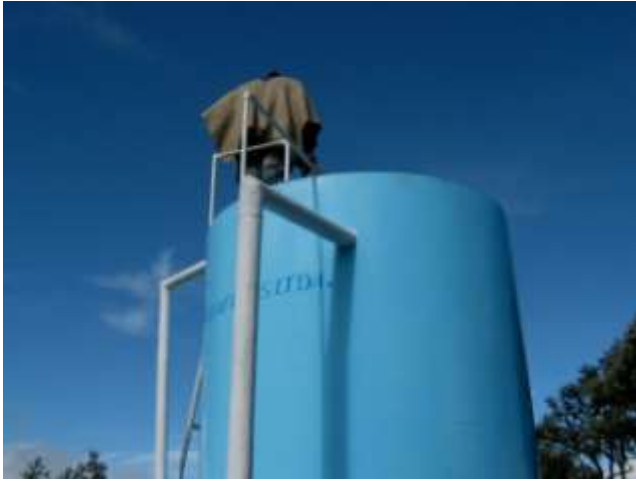
Planta de Tratamiento Vereda Chipacatá..
