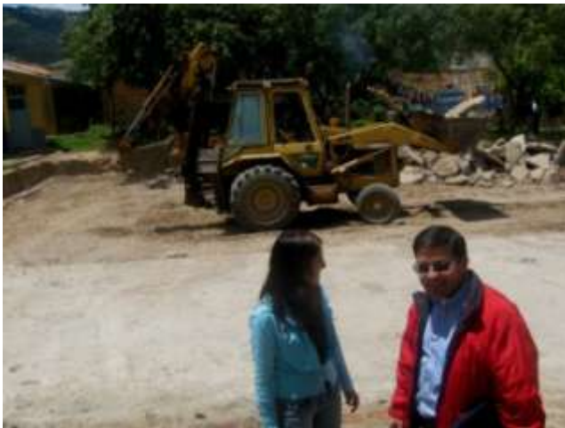
Construcción Cancha de Mircofutbol
