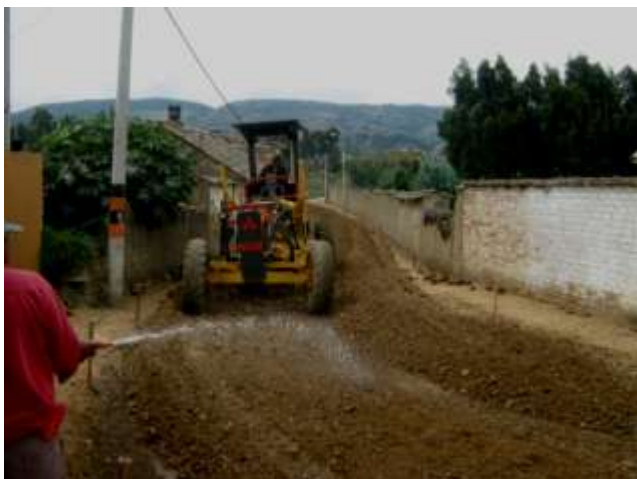
Instalación base Vía al Cementerio
