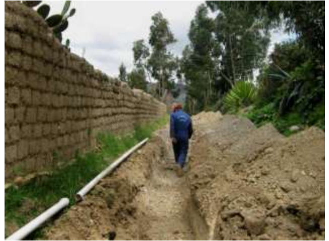
Ampliación de acueductos urbanos.
