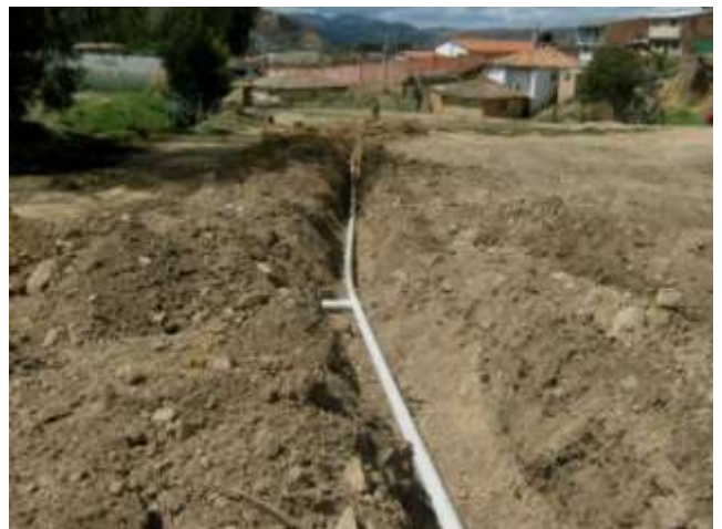
Construcción Acueducto para la Urbanización Villas de Cucaita
