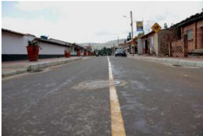
Pavimentación vía a Sora
