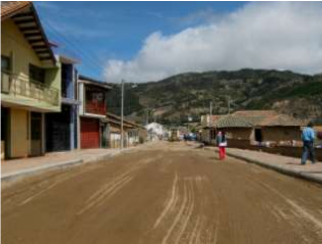
Alistamiento para pavimentación Calle 8
