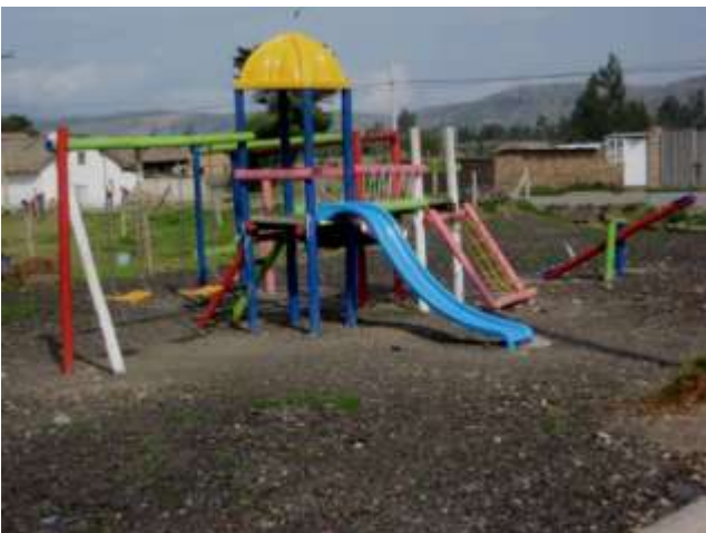
Construcción Parque Infantil
