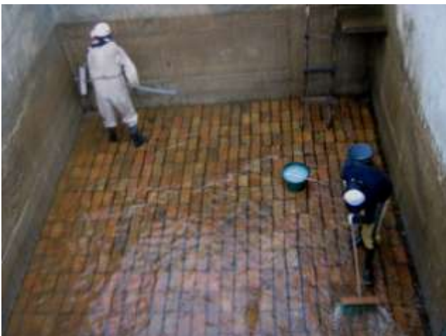
Limpieza y Desinfección de tanques de abastecimiento.
