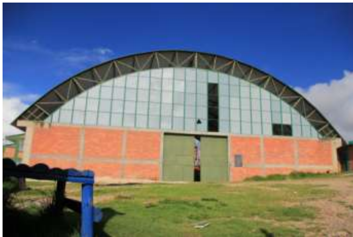
Cerramiento en acrílico del hastial del Coliseo de la Vereda Pijaos
