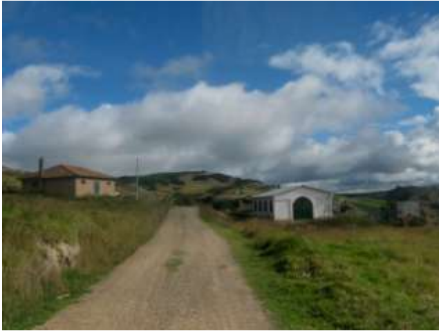
Mantenimiento vías rurales
