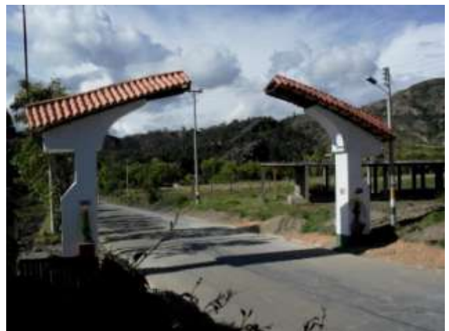
Construcción Portada de acceso al Municipio
