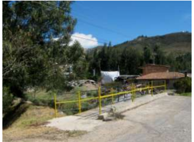
Construcción Puente Peatonal Sector Vidal Borda
