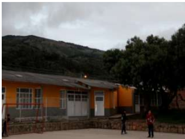
Terminación e Instalación de Redes Aula de Informática
