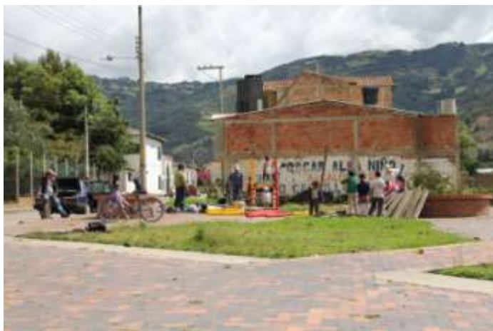
Construcción Parque Infantil
