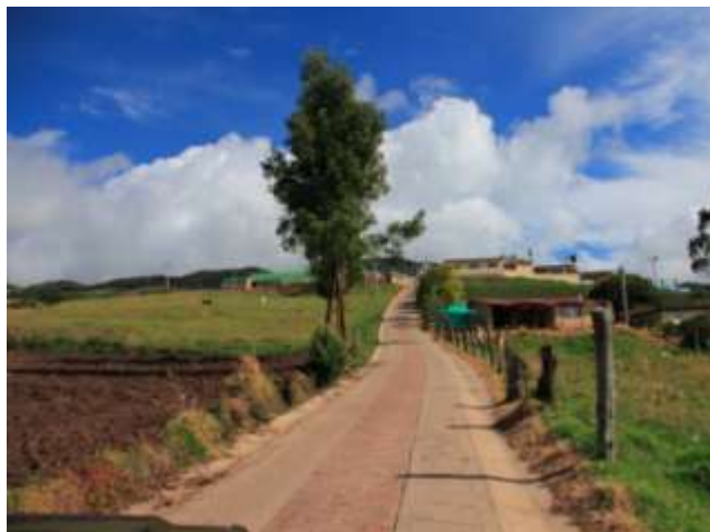
Construcción Placa huella Vereda Pijaos
