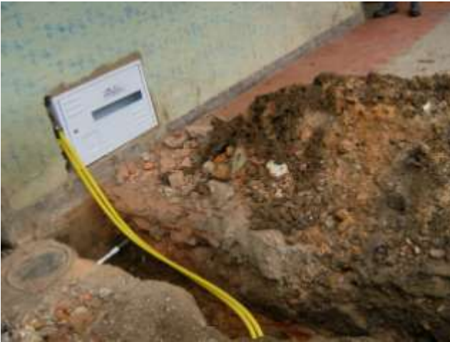
Ampliación Redes Gas Natural
