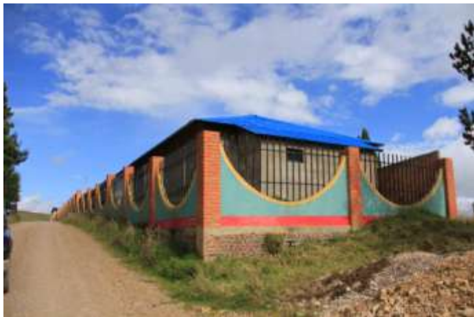
Construcción Salón Comunal Vereda Escalones
