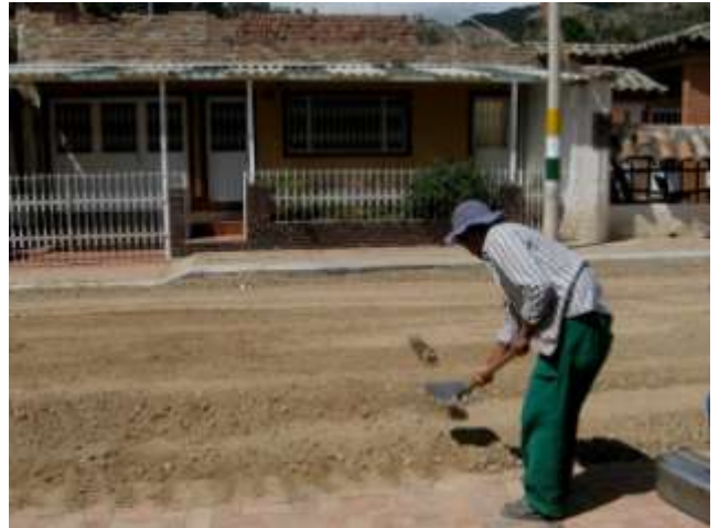
Instalación base para pavimentación
