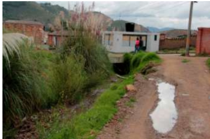
Construcción Puente Quebrada Gallinazos
