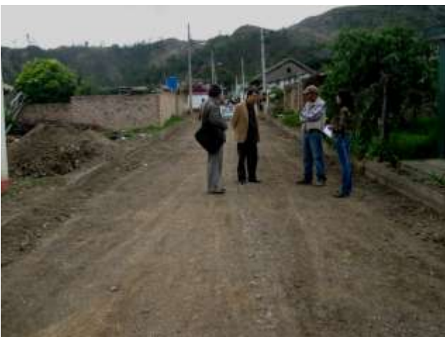
Pavimentación en asfaltita carrera 4
