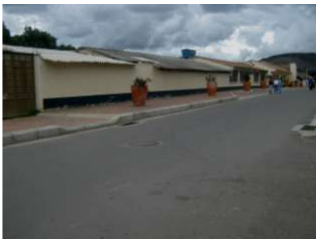
Pavimentación y construcción de andenes Calle 8
